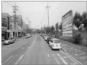
봉동읍 둔산공원 노상주차장 조성
