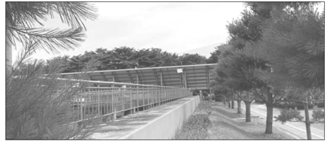
완주군은 완주산업단지 공공폐수처리시설 아름다운 건축로 만들기 위해 돌입, 마무리 단계에 들어갔다고 25일 밝혔다.
