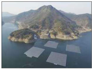
보령댐 수상태양광 설치 모습. (참고자료, 사진=전북도 제공)
